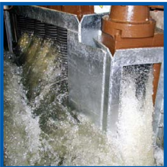
Фильтрация и измельчение твердых включений сточных вод с помощью фильтра и Мюнчера
